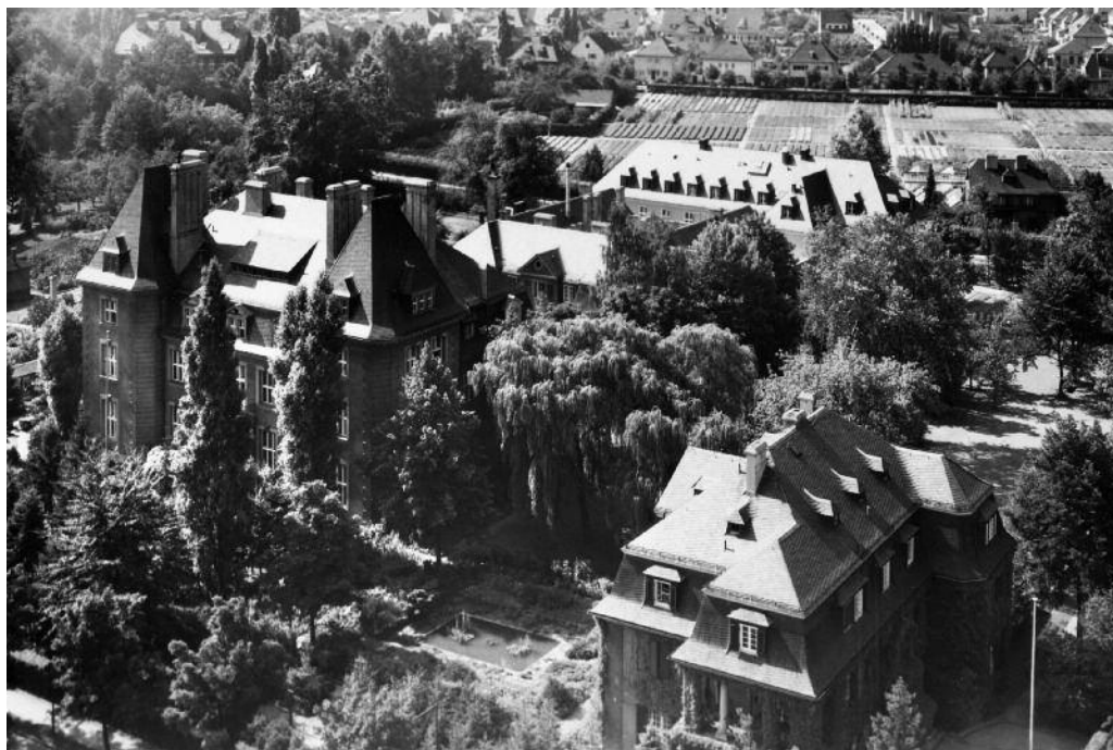
102. Blick vom Turm der Jesus-Christus-Kirche auf das Kaiser-Wilhelm-Institut für physikalische Chemie und Elektrochemie und seine Direktorenvilla (vorne rechts), im Hintergrund der sog. Röntgenbau (um 1939).
