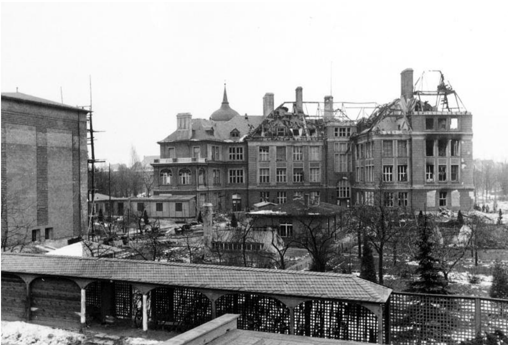
139. Rückansicht des Instituts mit Minerva-Bau (links) nach dem Luftangriff 1944
