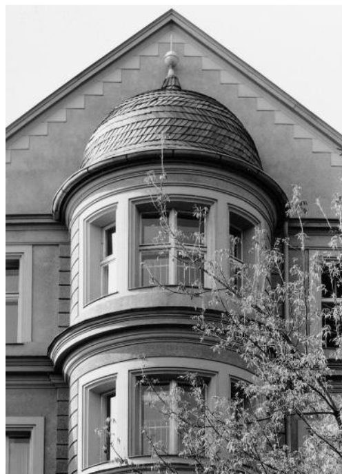
36. Treppenturm an der Ostseite
