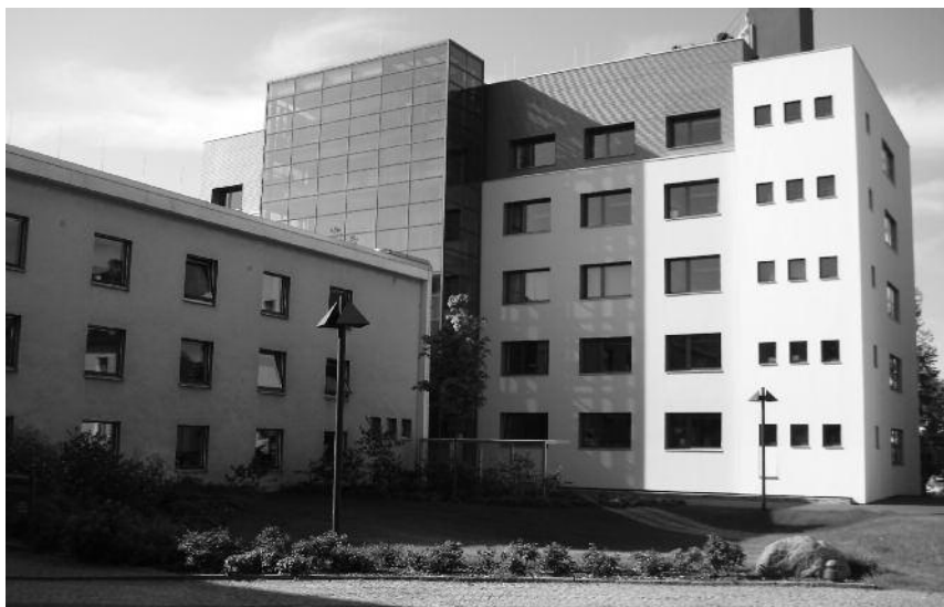
106. Das 2008 umgestaltete und erweiterte Gebäude des ehem. Instituts für Elektronenmikroskopie, heute Abt. Anorganische Chemie
