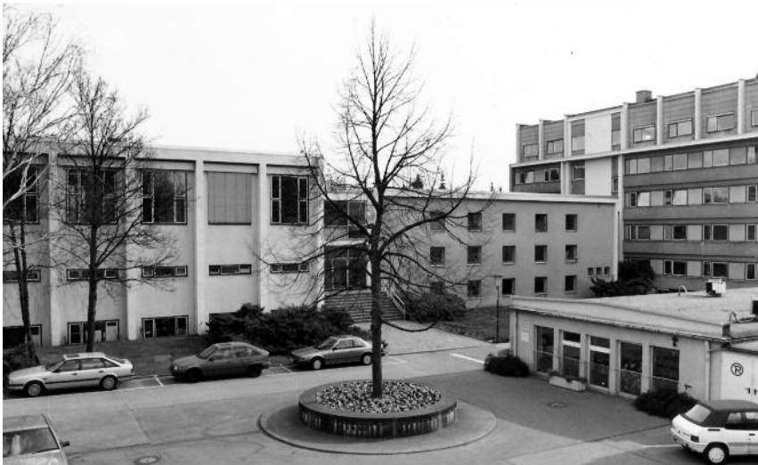
105. Nachkriegsbauten, von links: Hörsaal- und Bibliotheksgebäude mit Verwaltungstrakt, Institut für Elektronenmikroskopie
