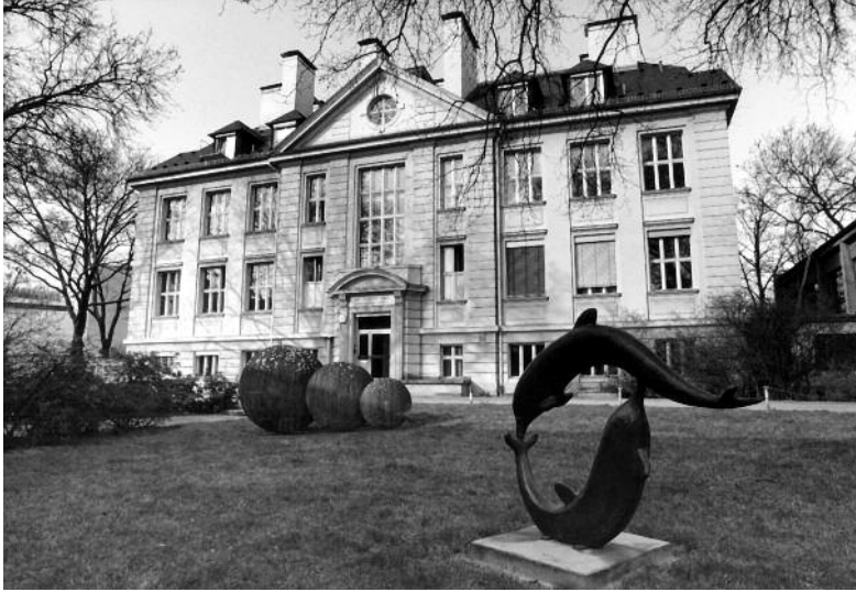
158. Südseite mit Haupteingang
